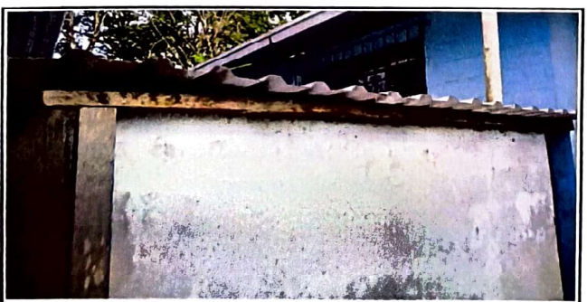
Foto 5: Pila de captación de agua reparada.
