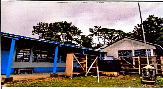
Foto 1: La cubierta de la parte frontal terminada.
