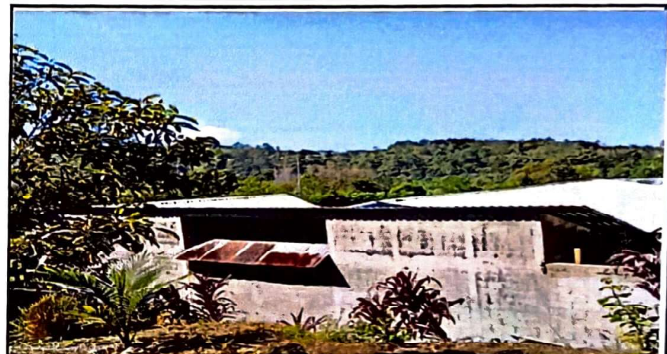
Foto 2: Vista de la parte de atrás terminada
